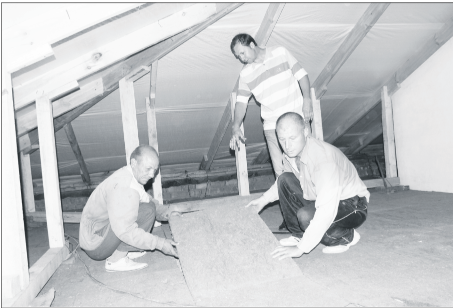
Отделочники «Домстрой» Алексей Ярушкин и Сергей Абдульманов под контролем главного инженера утепляют чердачное помещение. Фото автора.
